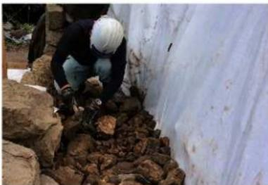
第49図 背面石垣の裏込め施工状況
