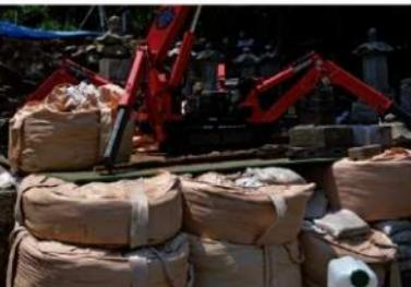
第26図 敷鉄板と大型土のうの設置状況
