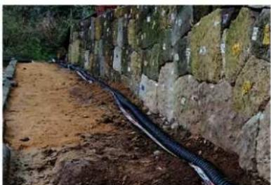
第52図 背面石垣前面のドレンーパイプ設置状況
