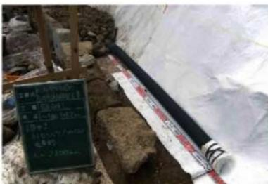
第51図 背面石垣後方のネットロン設置状況
