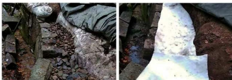
第56図 西面石垣の裏込め施工状況
