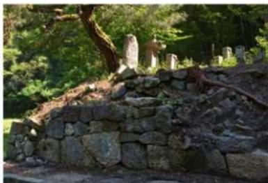
第102図 原位置を保つ背面石垣の凝灰岩系の石材
