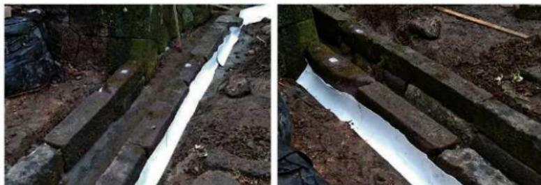
第83図 排水路縁石背面の防砂シート敷設状況
