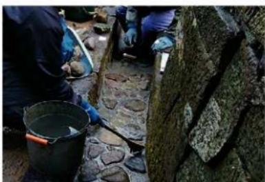
第80図 排水路底面石張りの施工状況
