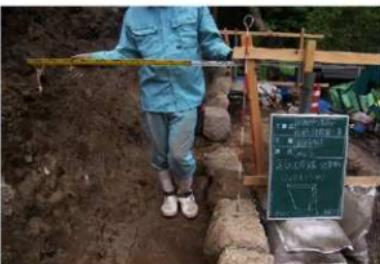
第43図 床掘り状況（左）と床掘り勾配および床掘り幅（右）
