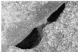
3 建物10 H-26P-1セクション(S→N)
