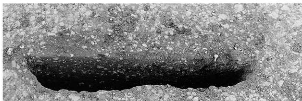
5 建物17 H-34P-1セクション(S→N)
