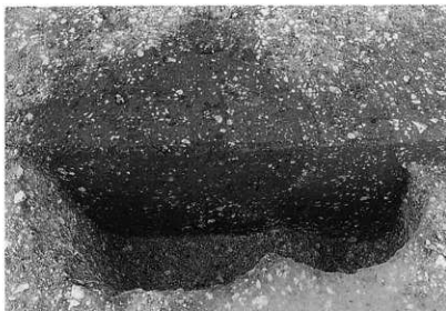
1 建物18 P-204セクション(SW→NE)
