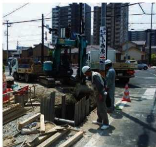
7区立会風景 (北西から)
