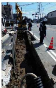
3区調査風景 (北西から)
