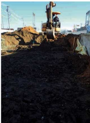
12区SZ550検出状況（南西から）
