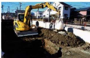
12区路床改良時立会状況（西から）
