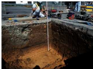
10区土層断面 (南から)
