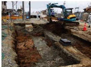
9区調査状況 (南から)
