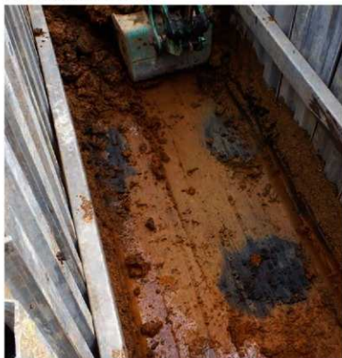
7区調査状況（南西から）
