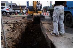
2区東側調査状況（南西から）
