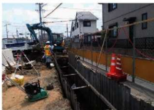
3区調査状況（北東から）
