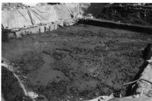
V面 全景(南西から)
