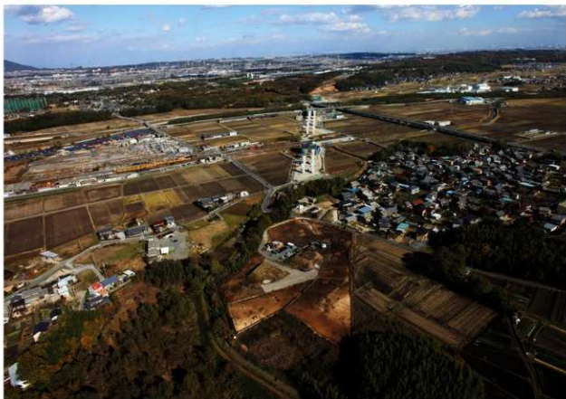
第2次調査区（南西上空から）
