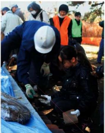
図8 復元瓦を基礎に埋め込む作業の様子
