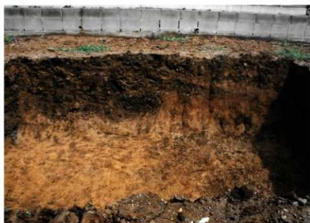
南向き壁断面
