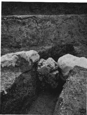
図11 景石据え付け状況
