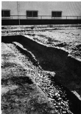
2 SX1上部地業状況(西北から)
