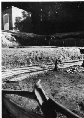
2 SX 4-り土留め
