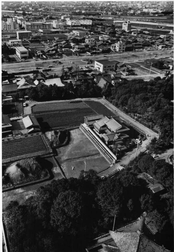
調査地遠景（南東から）
