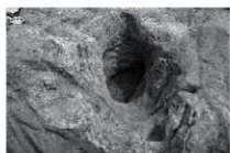
排煙口 (南下方から)
