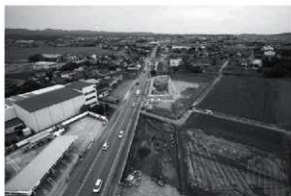
調査地遠景（小松方向から福井方向へ）
