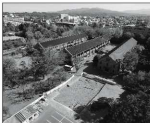
調査区遠景 (西から)
