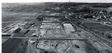
調査区遠景 (東から)
