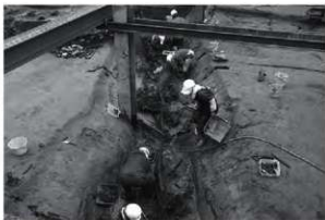
環濠 1 調査風景 (東から)
