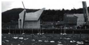
復元した板塀・櫓列（現地説明会）
