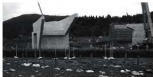
復元した板塀・櫓列（現地説明会）
