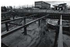
環濠 1・2 完掘状況 (西から)
