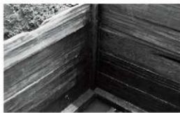
写真8 南東隅柱合わせ目（北西から）
