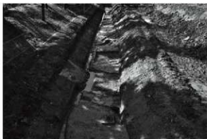
西側調査区完掘状況
