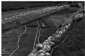
東調査区 用水路跡
