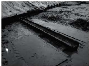
Ⅲ区木桶の盖板除去後
