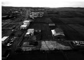
調査地上空から西方を望む
