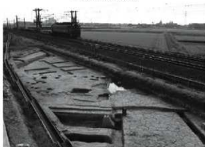
上層西半部完掘状況
