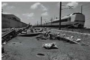
調査の様子 (北東から)
