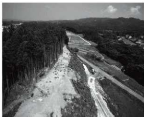
調査区遠景 (西から)
