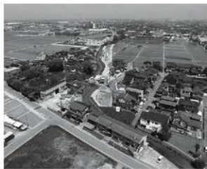
調査区遠景 (南南東から)
