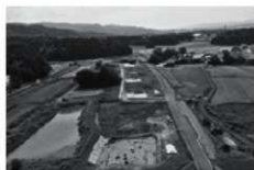
P1～P5区遠景（北東から）
