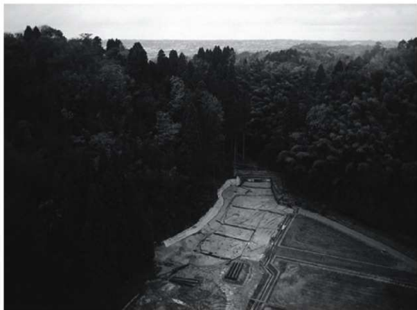
調査区空中写真（手前が南）
