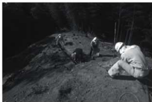
作業風景（斜面部トレンチ掘削）
