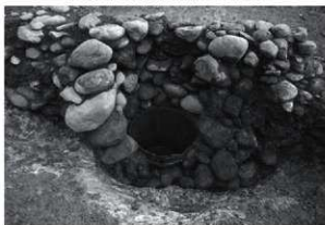
3区第2面石組井戸断割りと桶の検出（西から）
