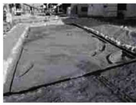
G区完掘状況 (南西から)
