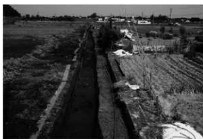
B区②完掘状況 (西から)
