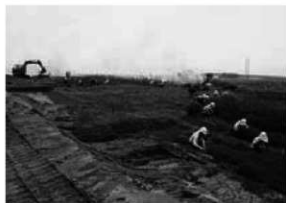
平坦面 (中段) 作業風景
