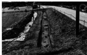
上層完掘状況(北東から)
