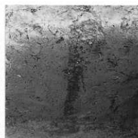
4 H-6・HP-2 断面 (南東から)
