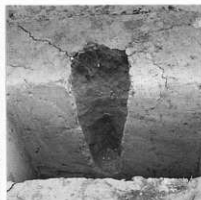
5 H-1・HP-11 断面 (南東から)
