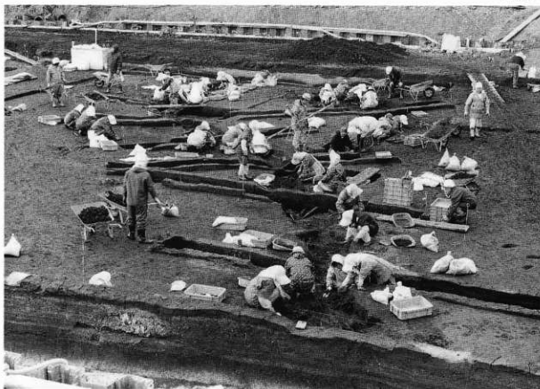
1 河道跡1の調査状況（南東から）
