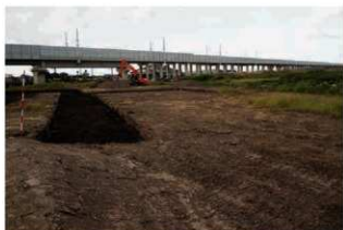
着手前(南西から)
