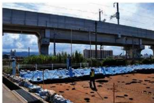
空中写真測量作業(北から)
