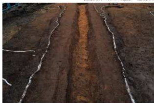
SD7新完掘状況(西から)
