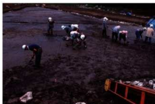
遺構検出作業風景 (西から)
