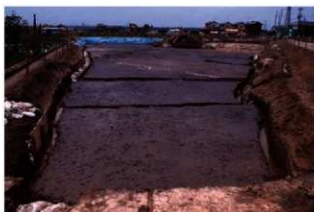
完掘状況 (東から)
