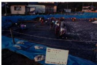
B 区試掘坑 1-2 掘削作業 (南から)
