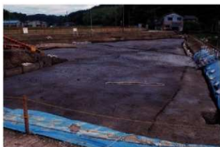
完掘状況 (西から)
