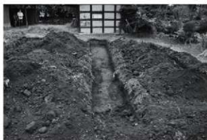
大日堂遺跡②トレンチ 2
