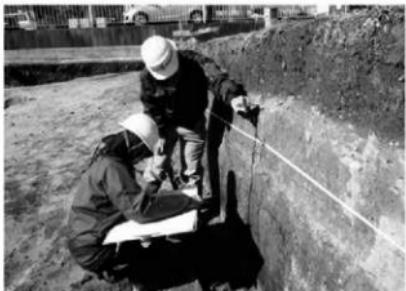
写真6 壁断面実測状況
