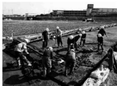
写真2 人力掘削作業状況
