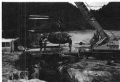
写真1 石材の吊り出し風景(北西から)
