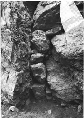
3 西袖石部分(北から)
