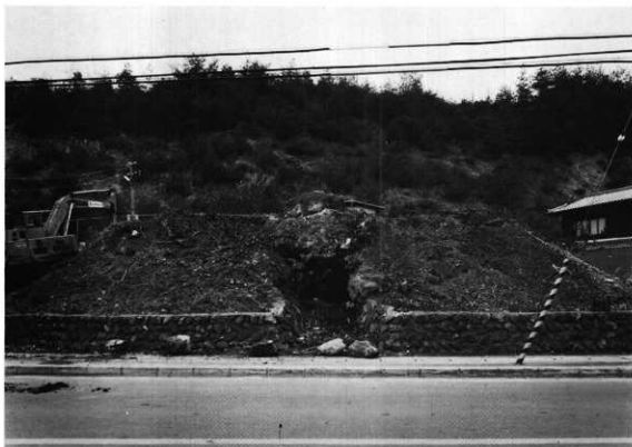
1 調査前の全景(南東から)
