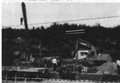
写真3 石材吊り出し風景（南東から）
