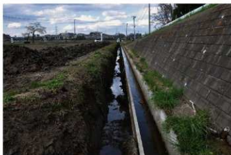
② 掘削後状況（南から）
