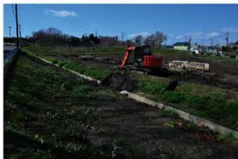
① 調査前状況（北東から）
