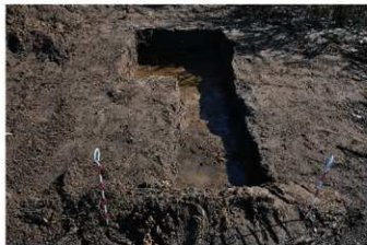
③ 2トレンチ 完掘状況 (2) (西から)
