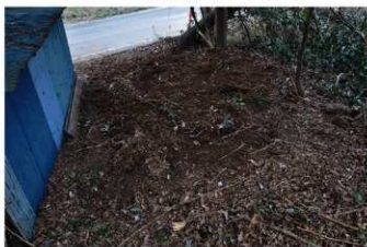
⑥ 8トレンチ 埋め戻し完了状況（南東から）
