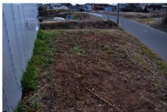
⑤ 7トレンチ 埋め戻し完了状況（北から）
