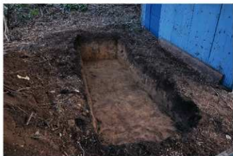
① 8トレンチ 完掘状況（北西から）
