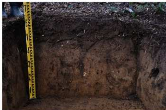
④ 8トレンチ 南東壁断面状況（北西から）
