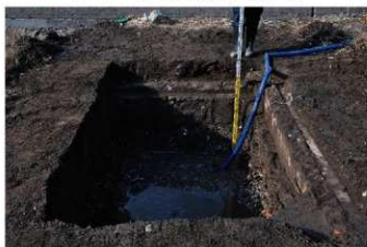
⑤ 3トレンチ 完掘状況 (2) (南東から)
