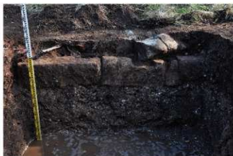
⑧ 2トレンチ 南東壁切石列検出状況（北西から）
