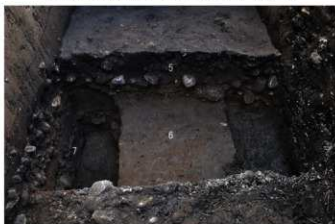
④ 26トレンチ 深掘状況 (南から)
