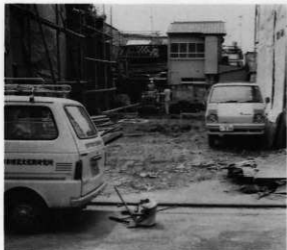
一般住宅立会調査
