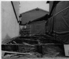
調査予定日以前に掘削終了
