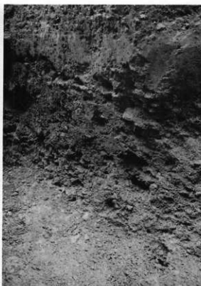
No. 2 地点断面（北から）
