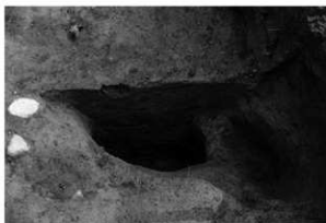
第5号竖穴建物跡 柱穴2 断面 (北西→)
