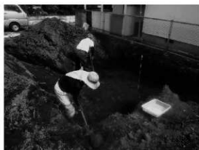
掘削作業状況 (2)
