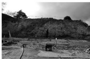
東側土塁工事立会（東から）
