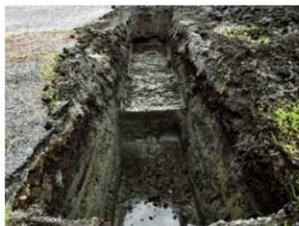
写真15 中津城下町遺跡①トレンチ状況(南から)
