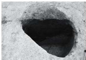
S K 51 断面 (西から)
