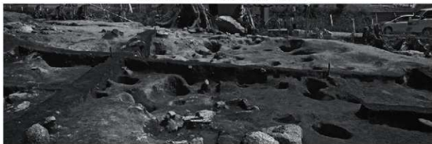
堆積土C断面 (A9・11号竪穴建物) (西から)
