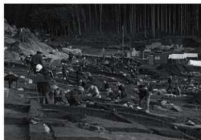
作業風景（平成26年度）
