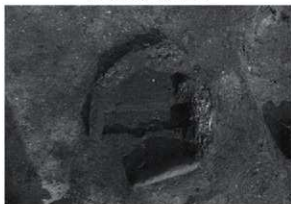
13号炉全景（南から）
