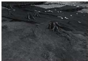
2号切土整地全景（南西から）
