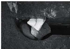
煙出し内燻堆積状況 (南から)
