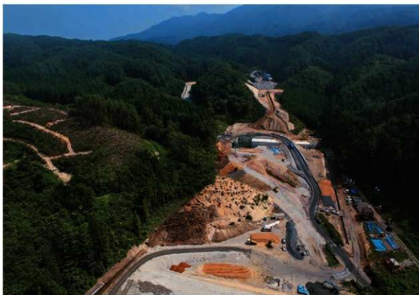
建設中の三陸沿岸自動車道と間木戸 1 遺跡（南から）
