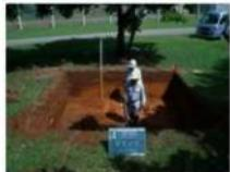
測量により試掘位置が確定された後で磁気探査による異常物や地下埋設物の有無確認を実施する。
