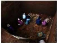
磁気探査により異常物や地下埋設物が無いことを確認した後は、重機掘削により試掘調査を開始する。
