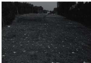
調査区 現況 (南から)
