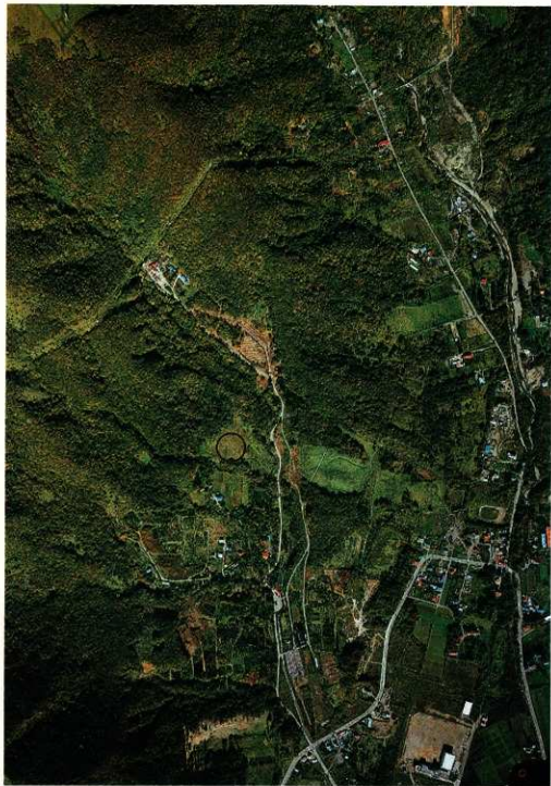
遺跡周辺の空撮写真
